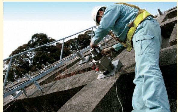
SAAMジャッキを用いた調査状況
